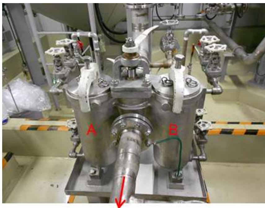
手前にポンプがある
