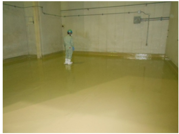
写真10 外部洗浄室床面補修塗装後
