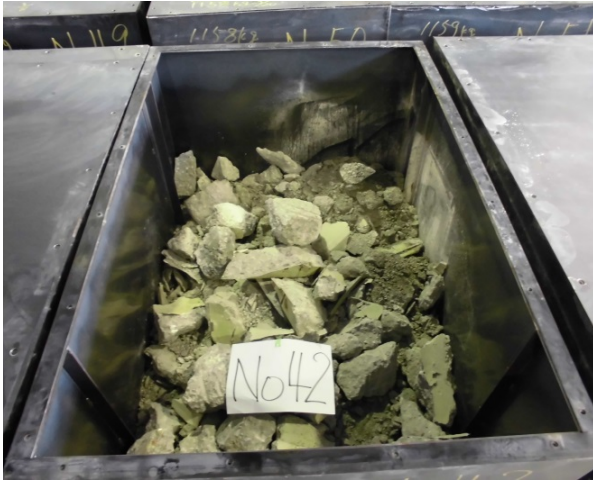
写真 15 解体撤去物箱詰状況例(ロット No.5)
