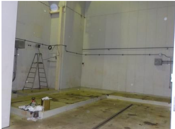
写真5 撤去後(外部洗浄室消音ボックス)
