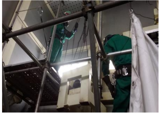
写真4 撤去状況(ロボットアーム)
