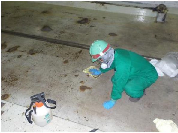
写真9 外部洗浄室設備撤去後
