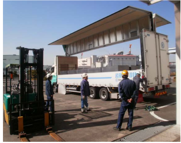
写真 16 解体撤去物の搬出状況
