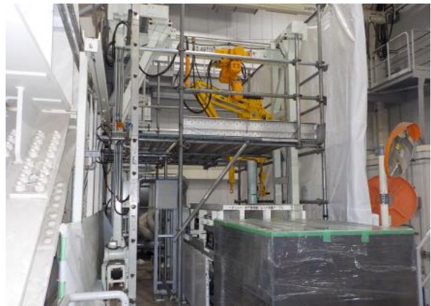
写真6 門型クレーン撤去前
