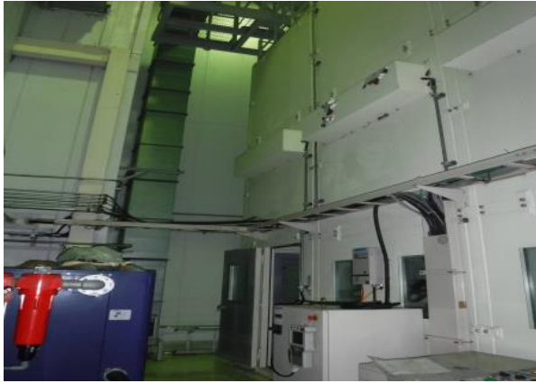
写真1 撤去前(外部洗浄室消音ボックス)
