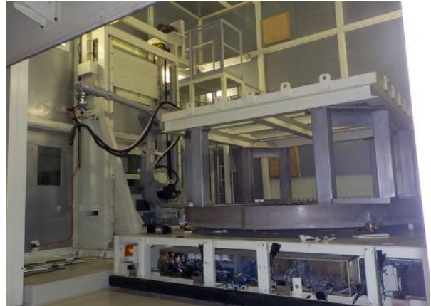
写真2 撤去前(ロボットアーム、台車他)
