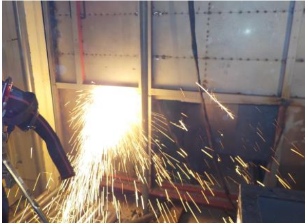
写真3 撤去状況(消音ボックス)
