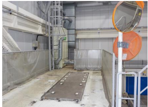
写真8 門型クレーン撤去後
