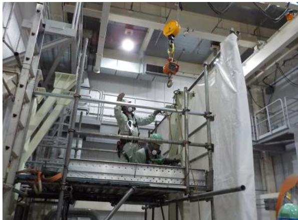
写真7 門型クレーン撤去
