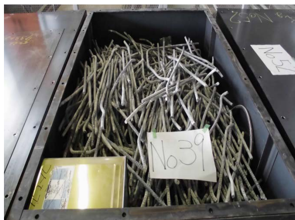
写真 12 解体撤去物箱詰状況例(ロット No.2)
