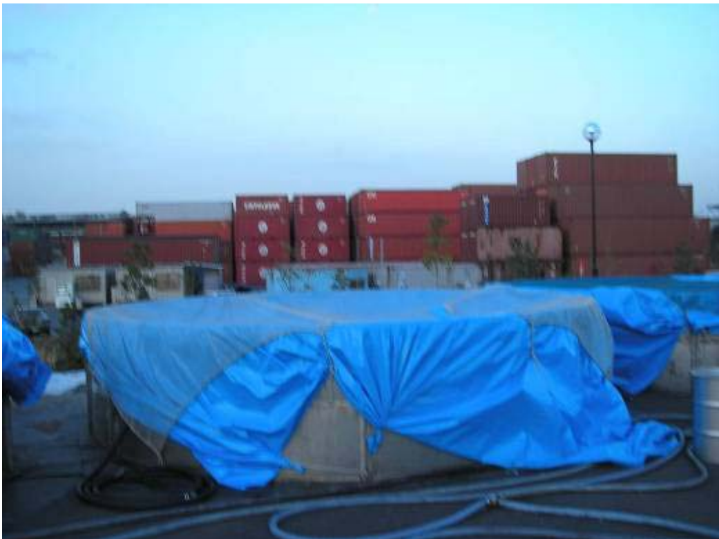
図 3-5 仮設タンク上面へのシート敷設
