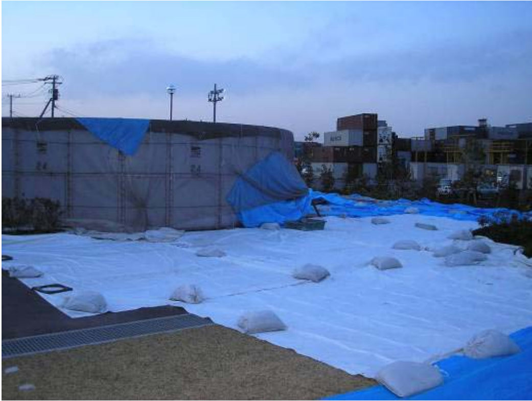
図 3-4 周辺舗装面及び芝生への雨水よけシートの敷設
