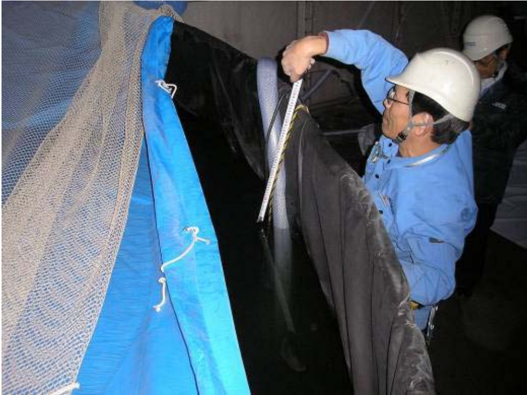
図 3-2 仮設タンクの液面低下措置
