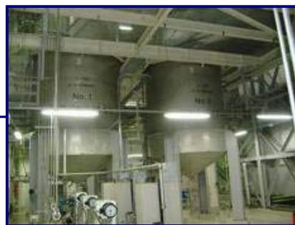
処理液バッファタンク
