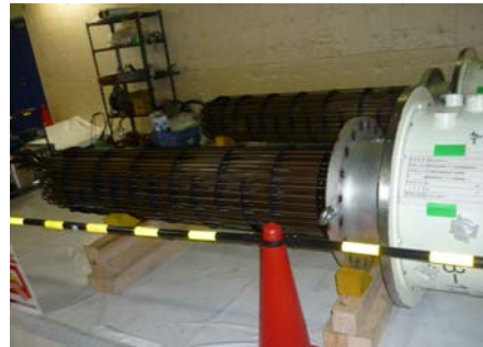
低濃度処理施設の一次蒸留器熱媒ヒーターオーバーホールの様子
