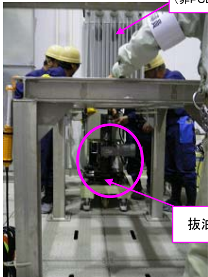
抜油装置(除染室) 取付け作業
