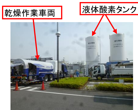
液体酸素タンク乾燥作業の様子
