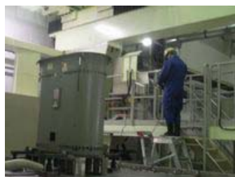
高圧トランス粗解体
