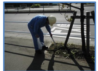
施設外周の清掃
