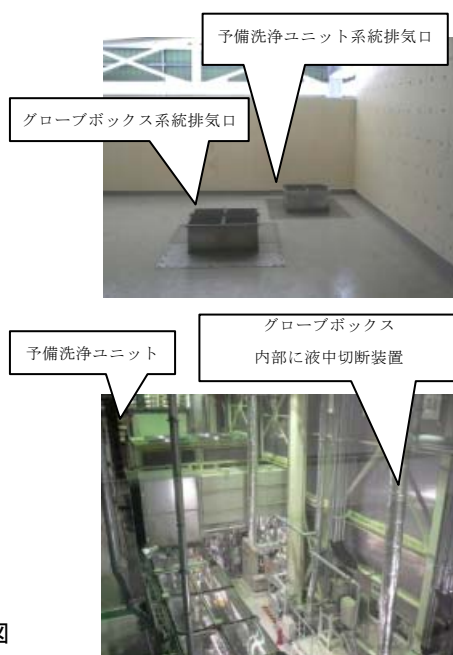
コンデンサ解体室内グローブボックス及び予備洗浄ユニット系統排気概念図
