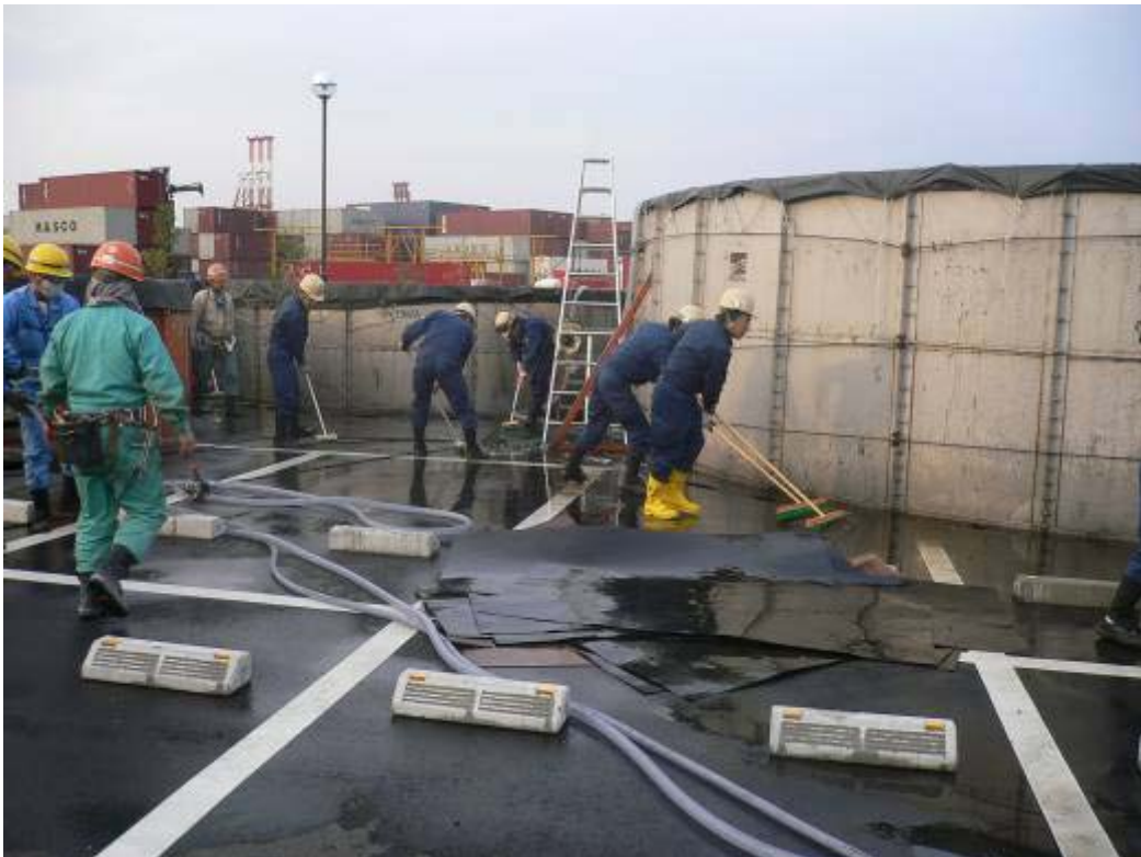
図 3-3 周辺塗装面(アスファルト)及び雨水側溝の洗浄
