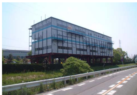
建設が進む仮設事務所
