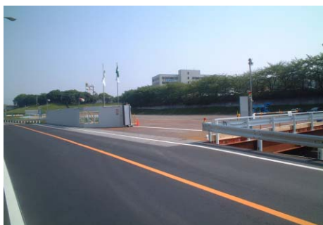
工事車両用仮設橋
