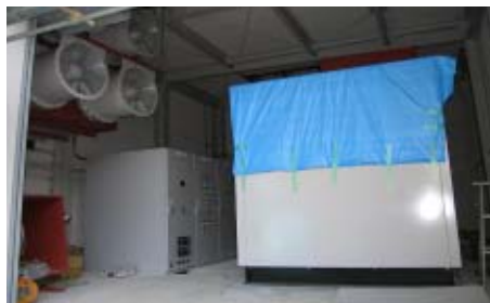
非常用発電機
