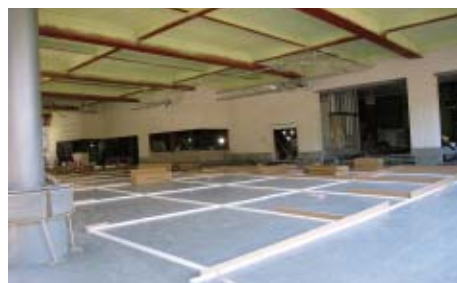
2階ピロティ シート防水施工状況
