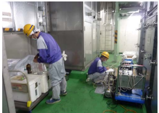
排気測定実施の様子
