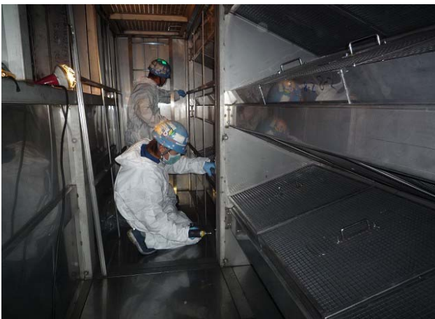
活性炭カートリッジ交換作業
