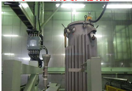
トランス油抜き取り 所定のプラグに抜油管を挿入し、トランス油を抜き取る。
