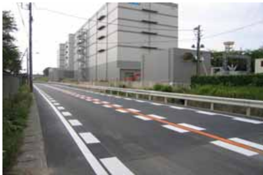
仮設橋撤去が完了した市道(広久手下細谷線)
