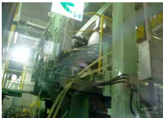
車載トランスからPCBの抜き出し
