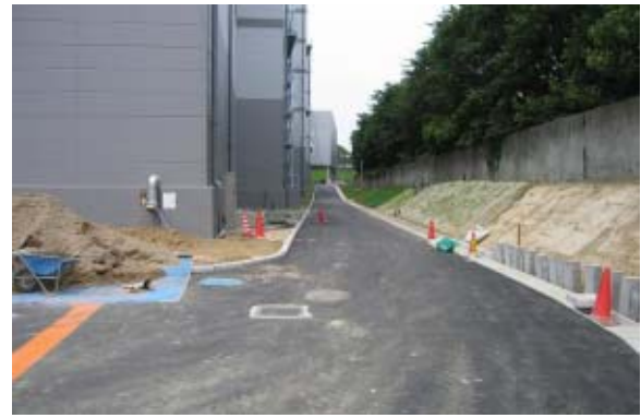
舗装完了(施設東側)
