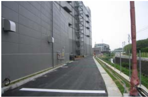
舗装完了(施設西側)
