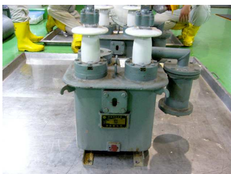
小型トランス(計器用変成器)
