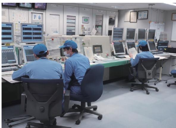
豊田施設の頭脳ともいべき場所で、各設備を分散型制御システム(DCS)を用いて24時間監視、制御しています。
