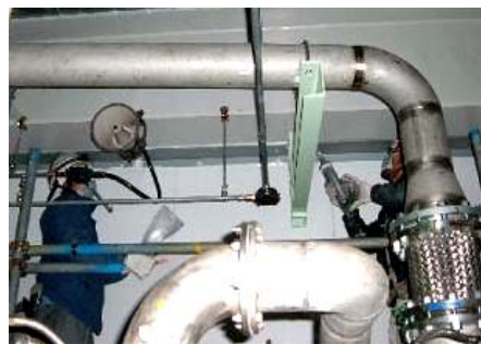
壁と梁の間に塞ぎ板を設け、シールを実施
