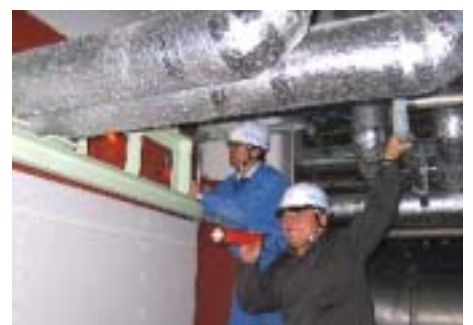
検査確認の状況
