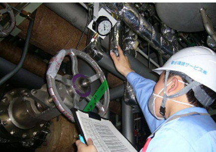
蒸留塔における作動確認
