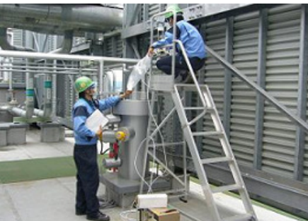
施設屋上排気口の環境測定
