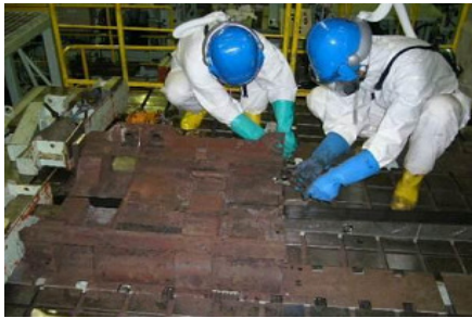
大型トランス缶体切断準備作業
