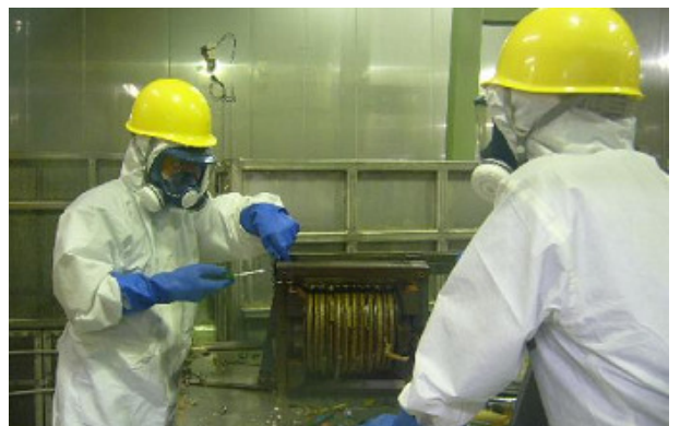
解体作業の実機教育状況
