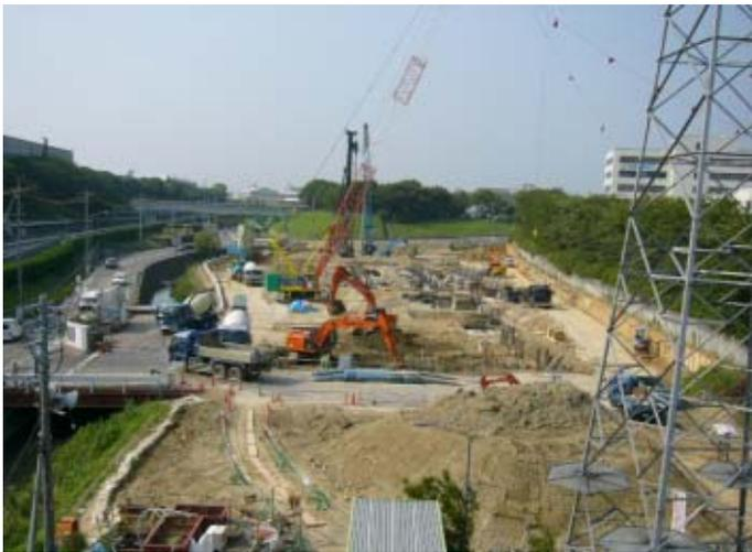
杭工事が6月に完了し、建物の基礎工事が本格的に始まりました。杭が設置された部分から掘削を始めており、鉄骨用アンカーボルトのセット、鉄筋型枠を組立て、コンクリートを打ち込みます。
