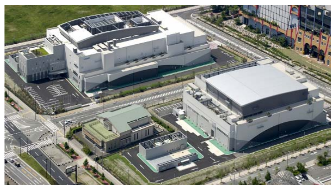
10月から開業した大阪PCB廃棄物処理施設
