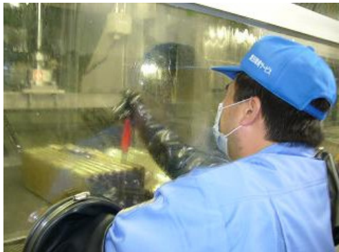
グローブボックスでの解体作業
