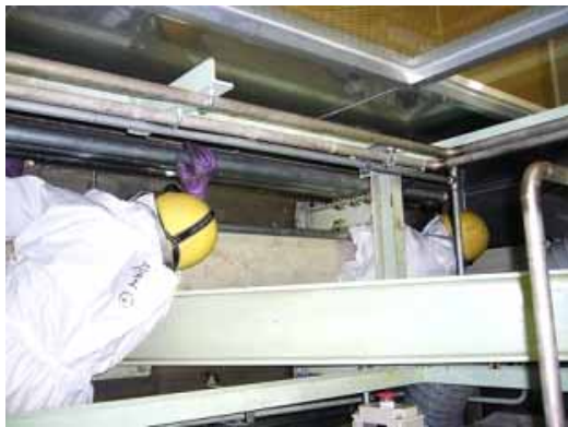
床下の点検・確認作業
