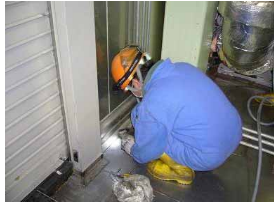
床面の補修作業
