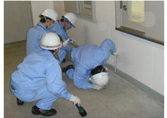
流出防止堤の点検
