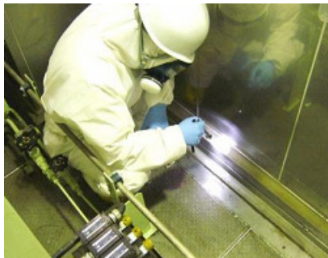
ステンレス壁床の遮へい状況の点検
