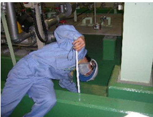
防油堤の点検
