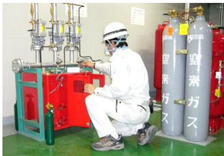
定期点検状況(防消火設備)
