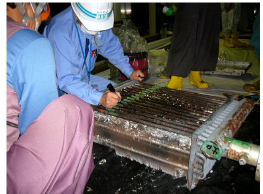
破損していない熱交換器の解体点検作業
