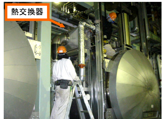
熱交換器の交換作業
