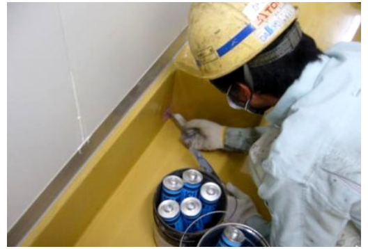
流出防止堤の再塗装
