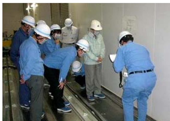
不具合対策を行った設備の現地確認
