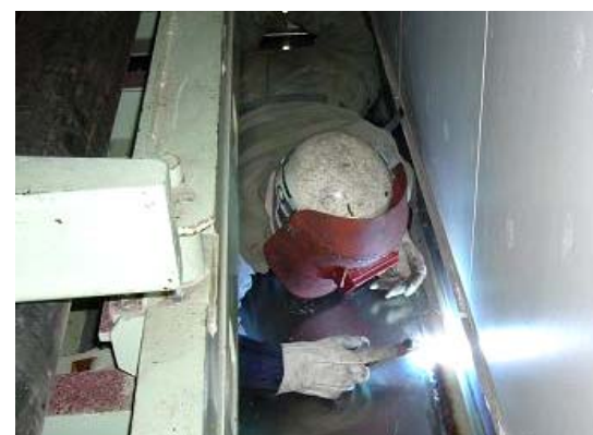
ステンレス床の補修作業(溶接)
