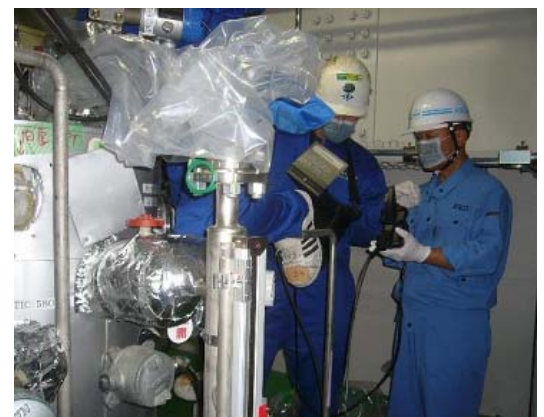
前回定期点検の様子(蒸留塔)
