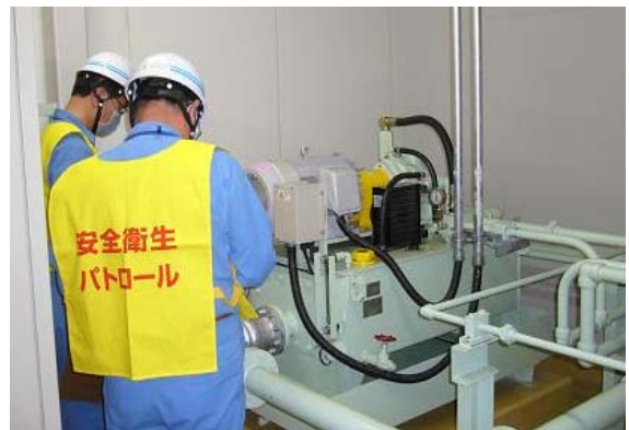
安全衛生パトロール状況
