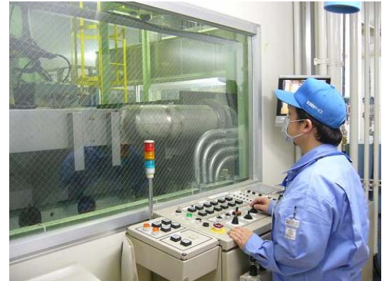
運転作業状況(小型トランス解体)
