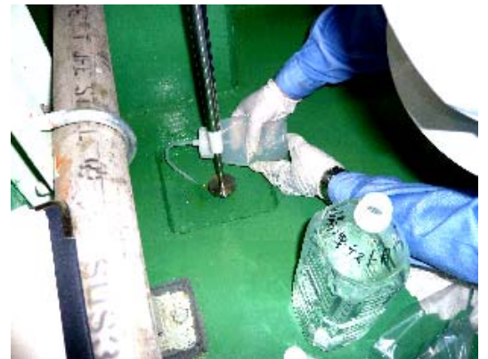
定期点検の状況(漏洩検知器)
