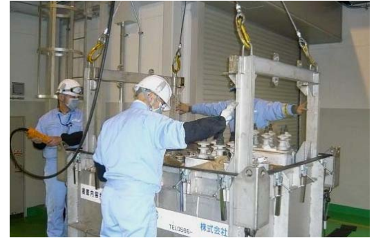
受入検査室におけるコンデンサの確認状況
