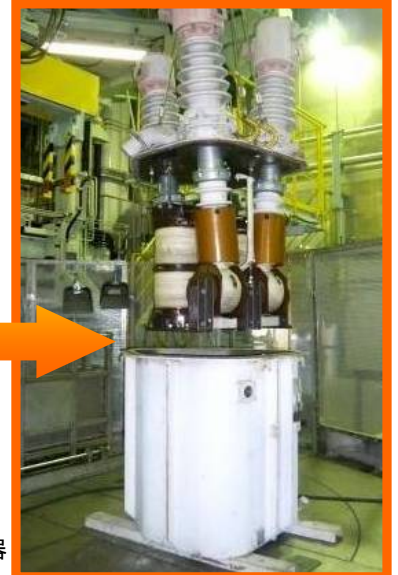
解体中の計器用変圧変流器
