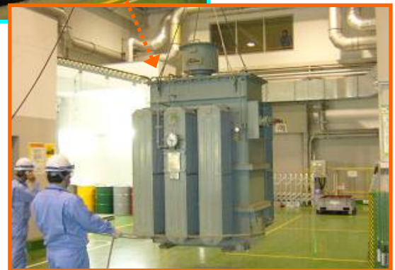
【写真下】大型トランスを受入保管エリアに搬入
