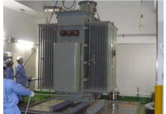
大型トランスの受入作業
