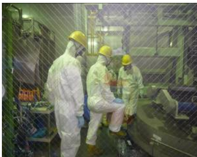
安全パトロールの様子
