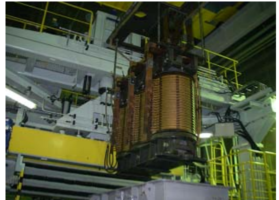
抜油洗浄後の大型トランス内の鉄心・コイルの取出作業
