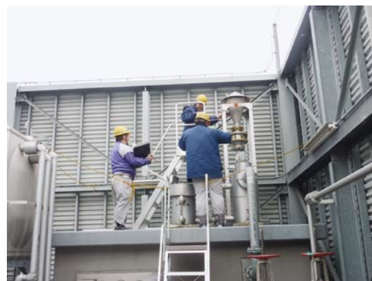
排気測定の様子
