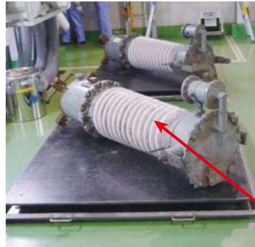
計器用変流器を受入れた時の状況 (この後抜油工程へ)
