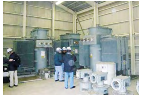
大型トランスの事前調査の様子
