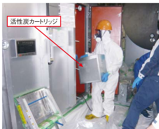
第2活性炭吸着槽 活性炭カートリッジの交換
