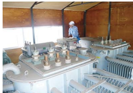
大型トランスの現地調査の様子
