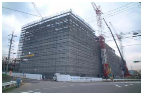
外壁ALC工事が進む北面
