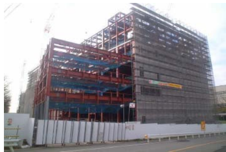
鉄骨建て方が完了した管理棟部分
