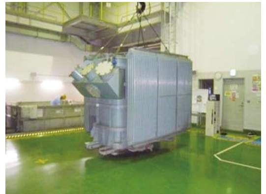
常設クレーンにて搬入作業中の様子
