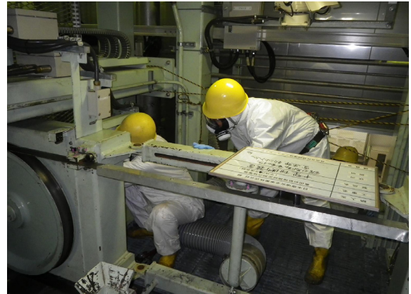
解体設備(中型切断機)点検の様子
