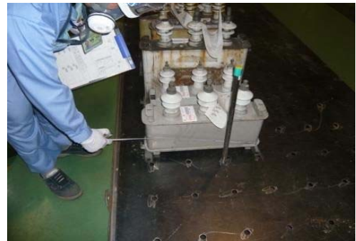
搬入されたコンデンサの点検の様子
