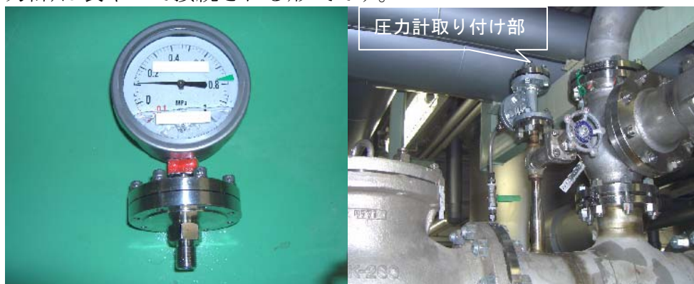
図3-1 脱落した圧力計
