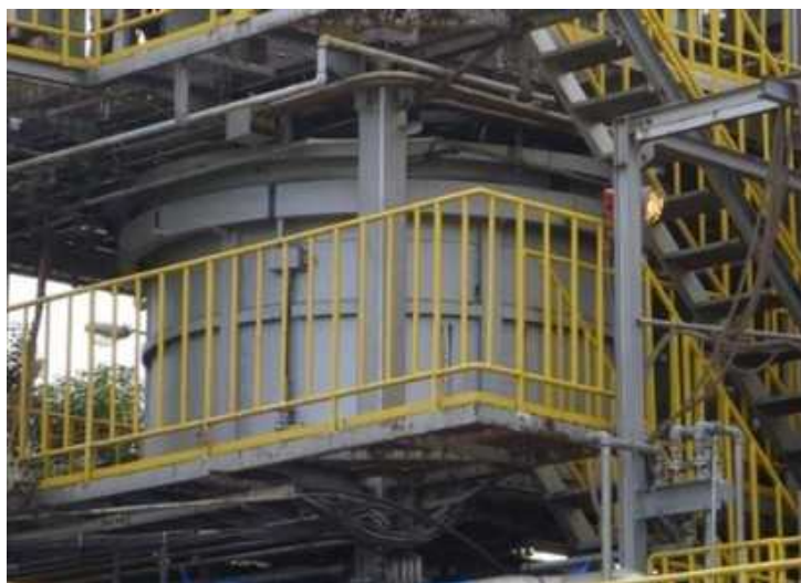
(B) 溶融炉本体 [Csを分離]
