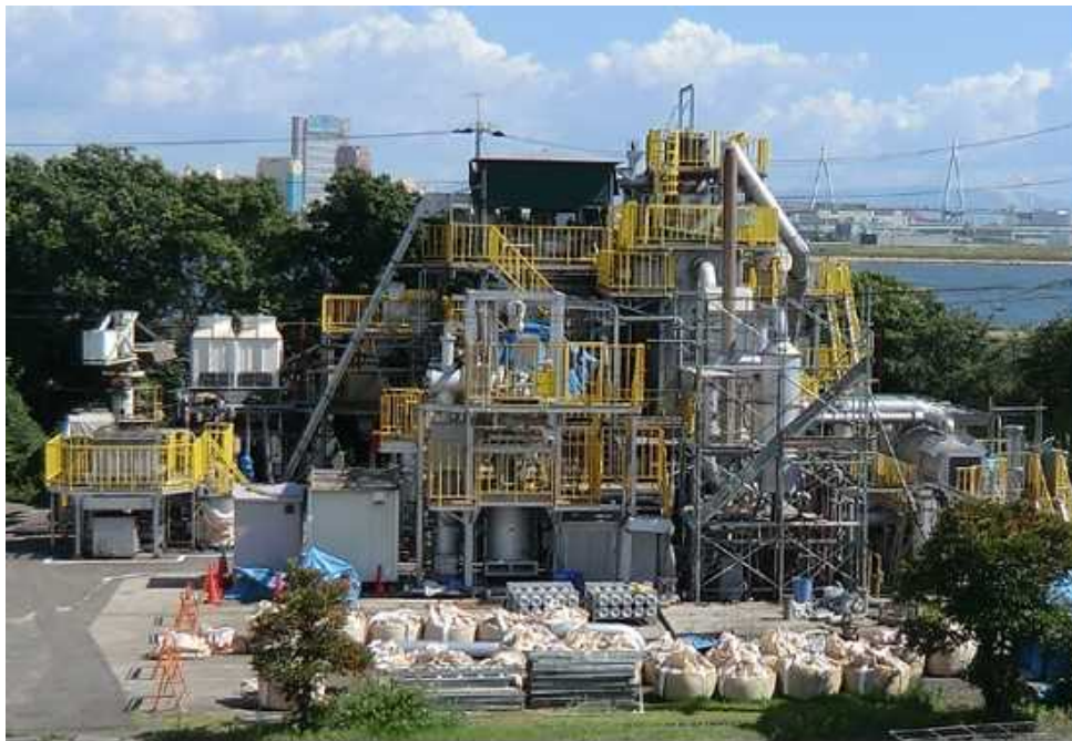
(B) 溶融炉本体 [Csを分離]
