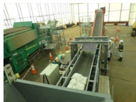
図2 濃度分別装置による現場試験
