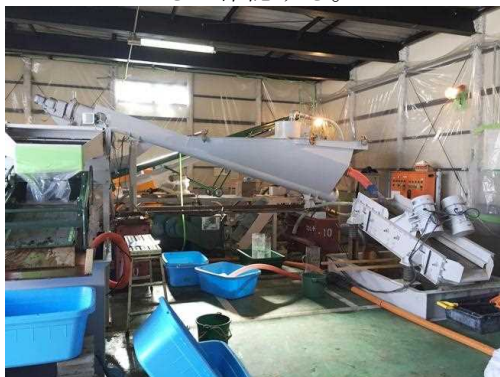
写真 3-1 屋内設備全景
