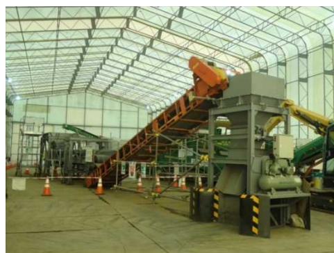
図 3-6 現場試験の状況
