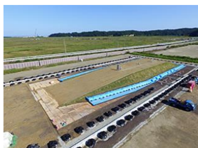
（再生利用実証事業施設）
