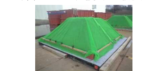
写真-8 実証盛土
